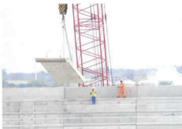
Foto 20: Lançamento de Escadas Pré-Moldadas
