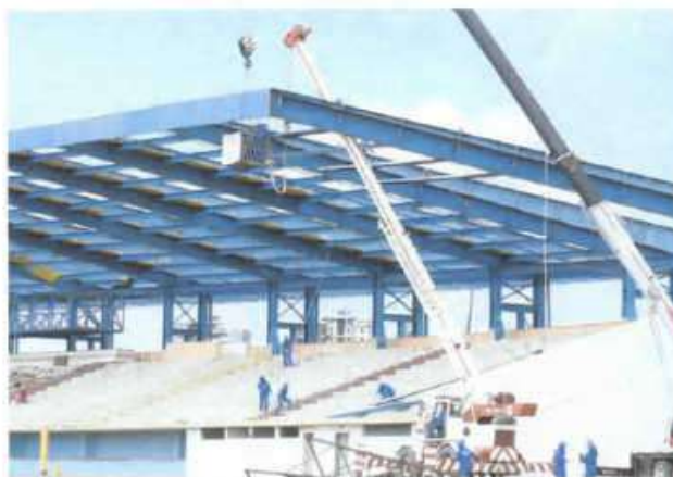
Foto 15: Desmonte de Estruturas Metálicas
