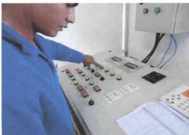
Foto 4: Controle Automação Central de Concreto
