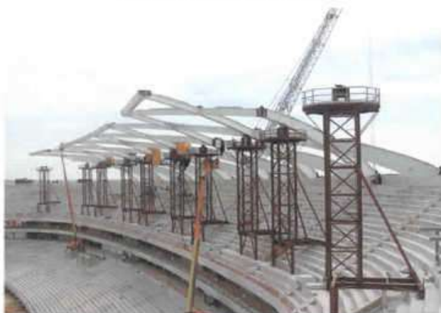
Foto 25: Torres de Montagem da Estrutura
