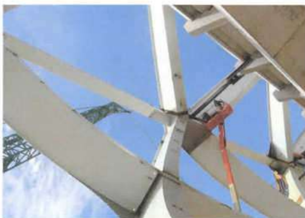
Foto 26: Soldagem da Estrutura Metálica
