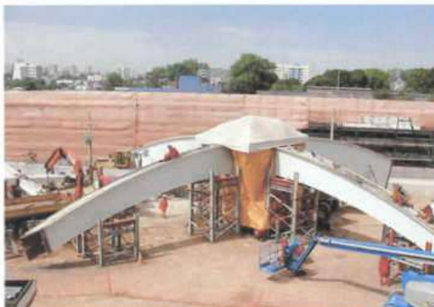
Foto 23: Pré-Montagem da Estrutura Metálica
